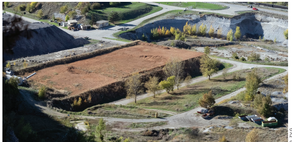
Die alte Chemiedeponie Gamsenried muss schnell, einmalig, sicher und definitiv saniert werden.
